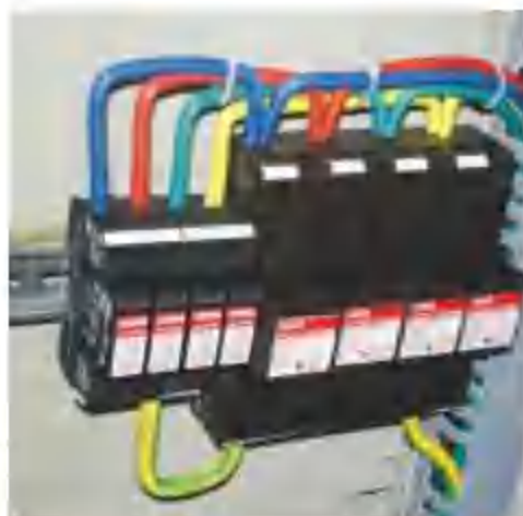
深圳外国语学校防雷整改工程
